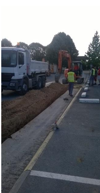
Réfection de la voirie « Rue des Ecoles »
